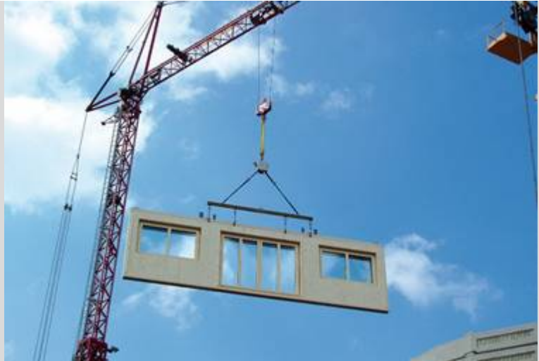
Abb.: hohe Sicherheit und eine massive Verkürzung der Montagezeit für Kran und Monteure sprechen für die TW-Balance
